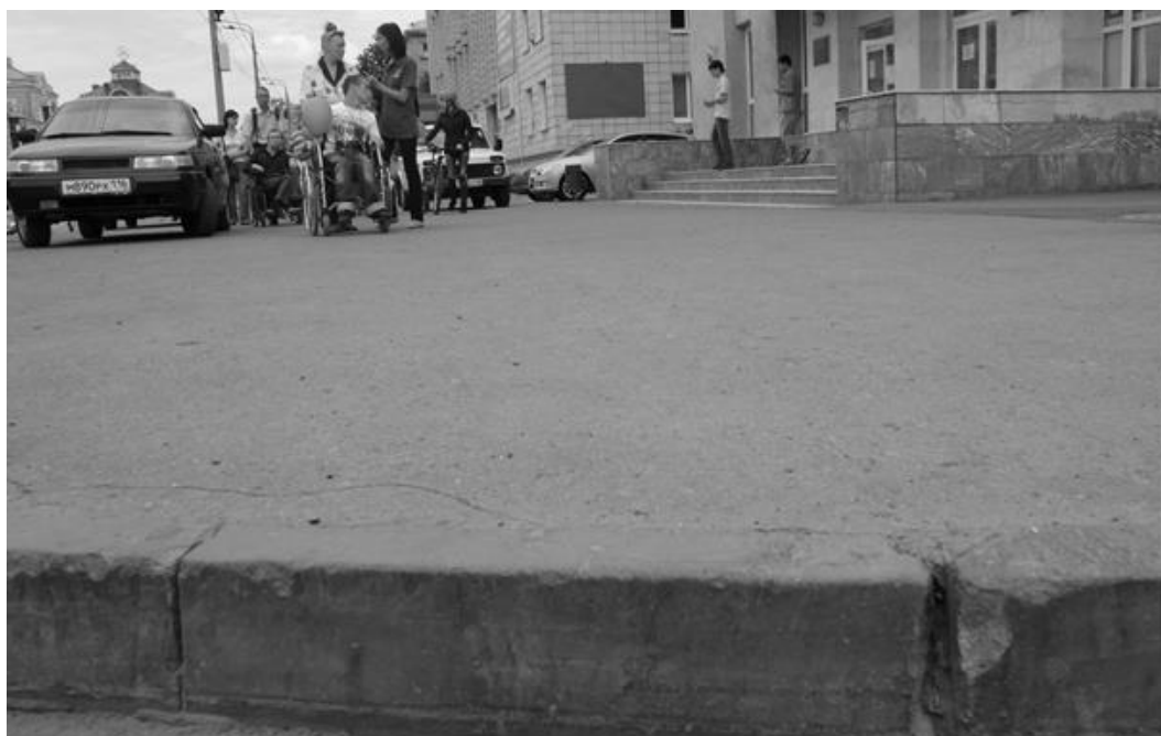
Ил.5. Высота бордюра на пересечении тротуара и проезжей части – 25 см. Автор снимка – Игорь Боталов
