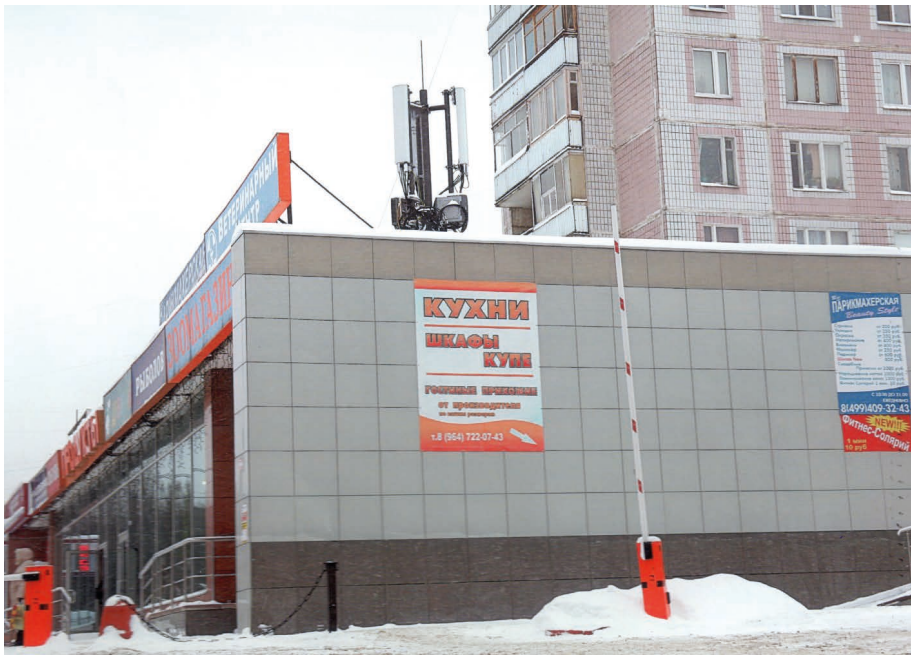
Рис. 2 – Размещение ПРТО на пристройке к жилому дому (Московская область, г. Видное, проспект Ленинского Комсомола, д. 35)
