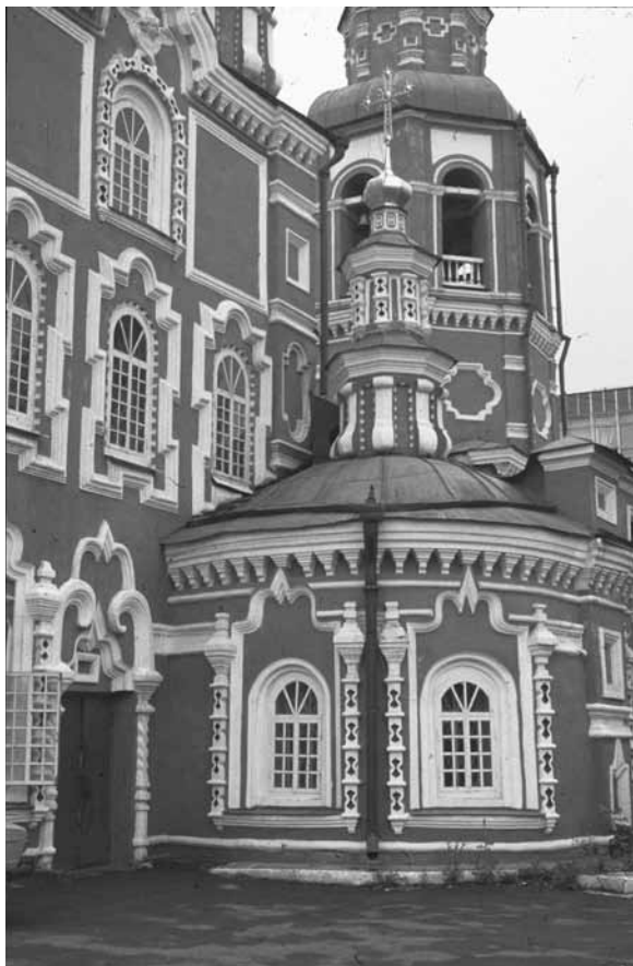
Покровская церковь в Красноярске. 1785–1789. Вид с северо-востока. Фотография автора, 2001 г.
