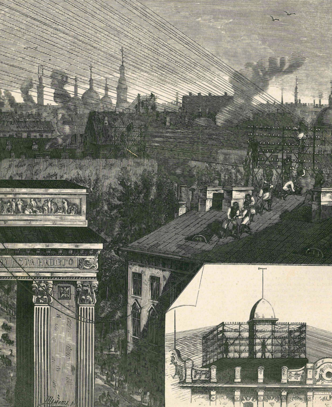
Санкт-Петербург. Устройство телефонов. Проведение линий от центральной станции. Павильон центральной станции на крыше дома Ганзена.
