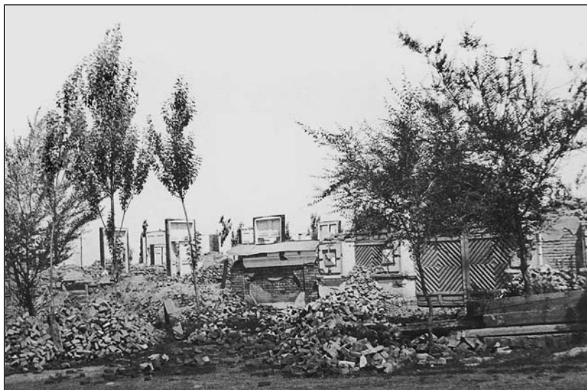
Здание в Верном, разрушенное землетрясением (1887). Уцелели только деревянные фрагменты дома [5].
