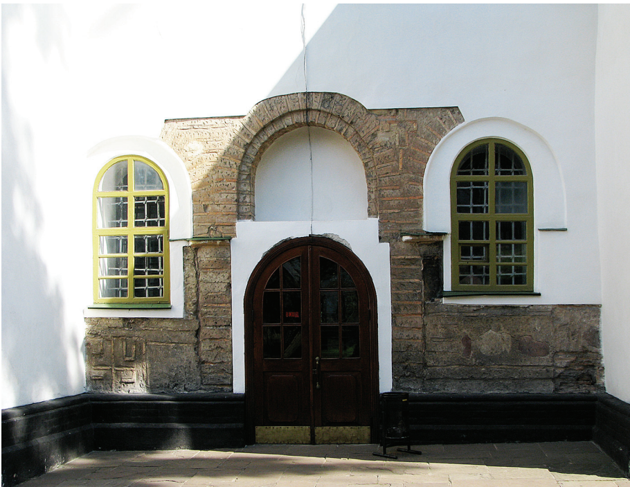
Ил. 9. Св. София Киевская, северный фасад галереи, кладка (фото Д.Д. Ёлшина, 2009 г.).
