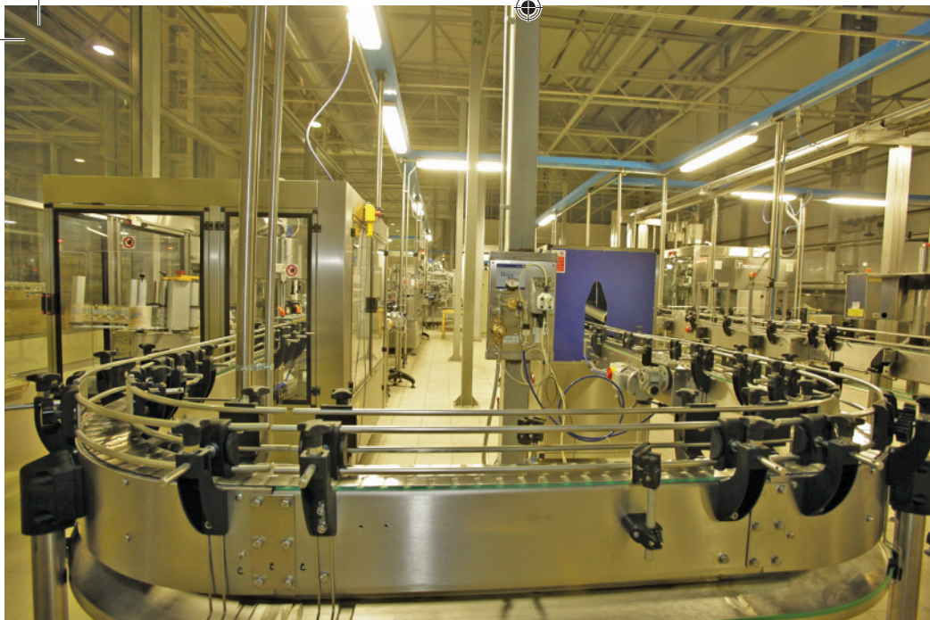
Пицунда. Завод по производству напитков
