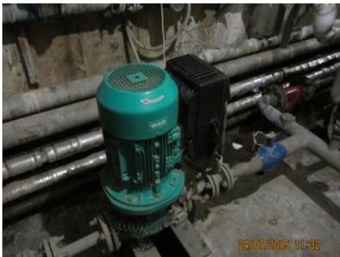
Фото 2. Насос системы ГВС с частотным регулятором.
