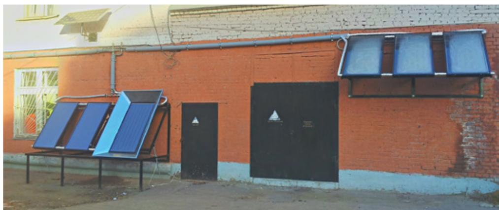
Рис. 2. Солнечные коллекторы и фотоэлектрический модуль в составе системы ГВС столовой.
