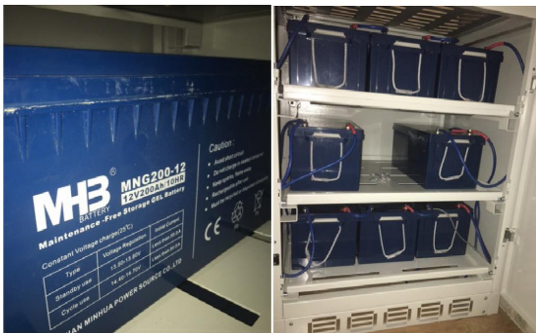
Фото 2, 3. Размещение аккумуляторов для накопления электрической энергии.
