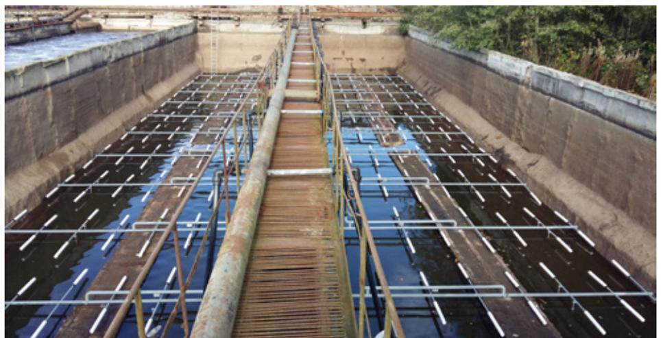
Рис. 1. Система аэрации.
