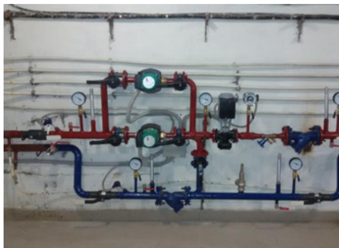
Рис. Смонтированный автоматический тепловой пункт в школе.
