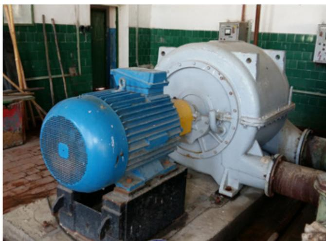
Рис. 2. Воздуходувное оборудование, установленное 15 лет назад.
