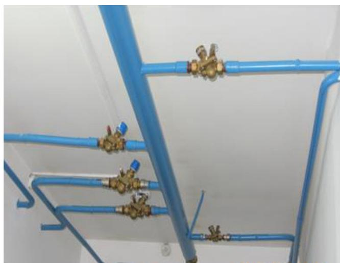
Фото 4. Автоматические балансировочные клапаны.
