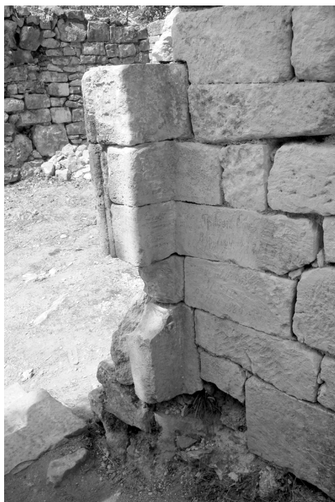
Илл. 47. Храм Св. Феодора в Анакопии. Фрагмент дверной четверти на западном входном проеме. Вид со стороны интерьера
