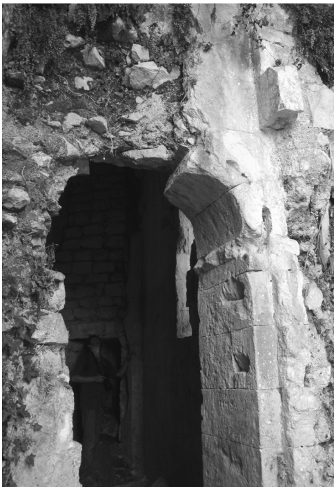
Илл. 56. Храм Св. Феодора в Анапоии. Арочный проход в северное помещение субструкций. Вид с юга
