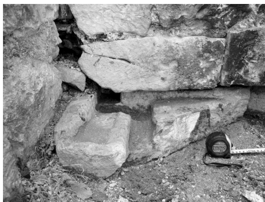
Илл. 17. Храм Св. Феодора в Анакопии. Левый блок-подпятник заложенного дверного проема в южной стене
