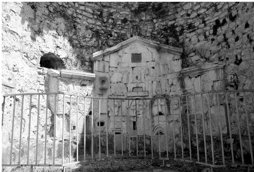
Илл. 6. Храм Св. Феодора в Анакопии. Алтарная часть. «Монашеская» стенка из фрагментов резных деталей
