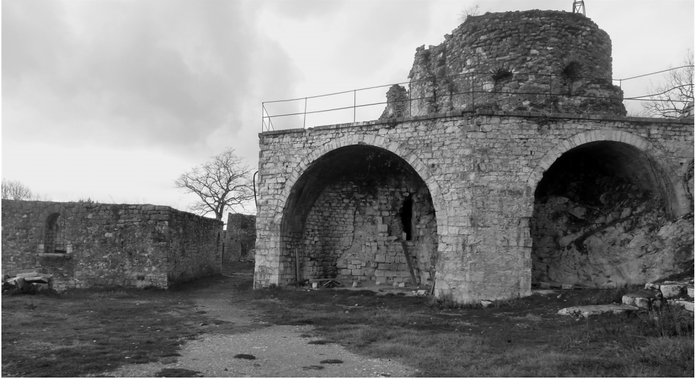
Илл. 53. Храм Св. Феодора в Анапоии. Субструкции и келейный корпус. Вид с востока
