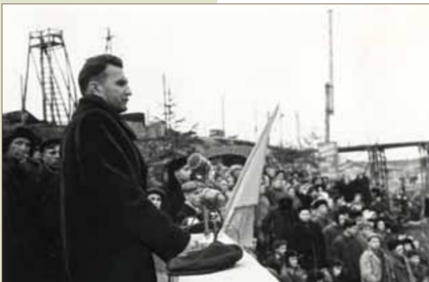
Митинг, посвященный закладке первого кубометра бетона в сооружение Воткинской ГЭС, выступает секретарь обкома партии К.И. Галаншин. Фото из фондов ПермГАНИ
