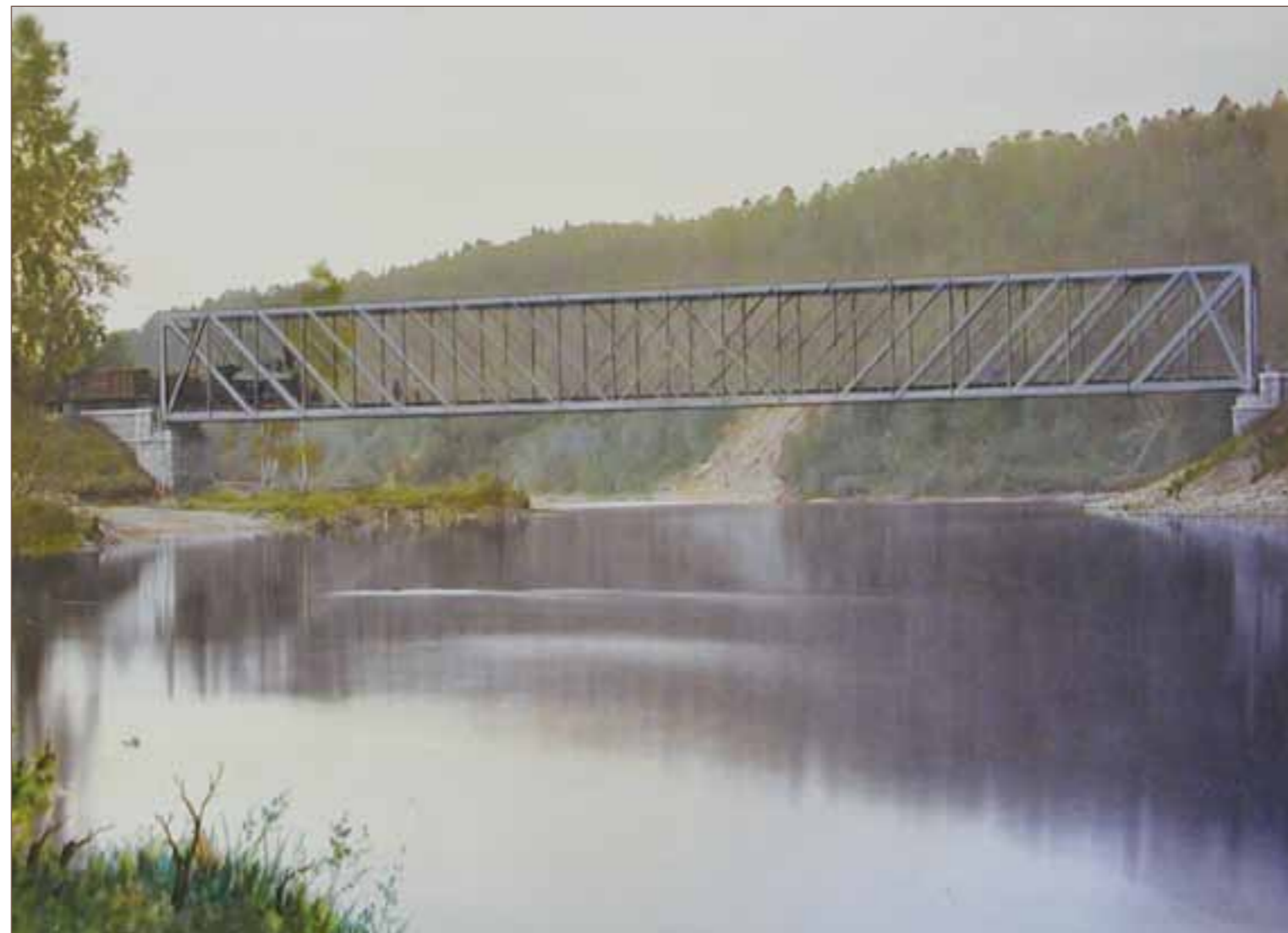
Мост через Вильву
