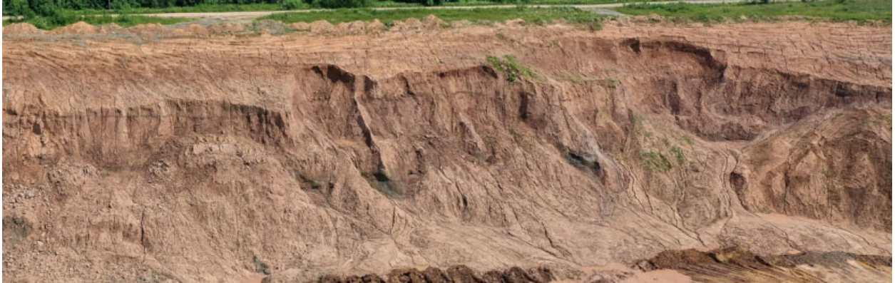
Рис. 2. Развитие эрозии верхнего горизонта кромки борта угольного разреза
