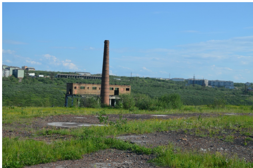
Mine à l'abandon, périphérie de Vorkouta (juillet 2018).
