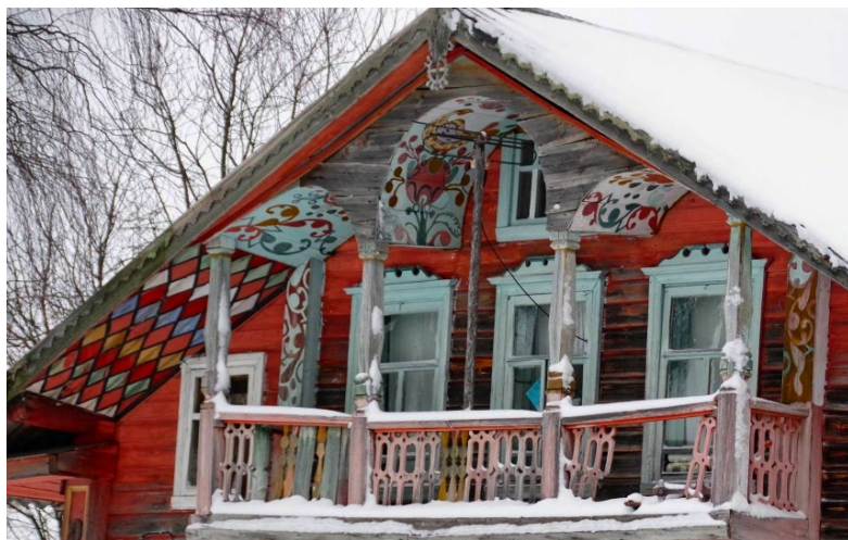
Рис. 2. Дом в д. Шоромская (Архангельская обл.) с расписным балконом и подшивкой свесов крыши. Кон. XIX в.
