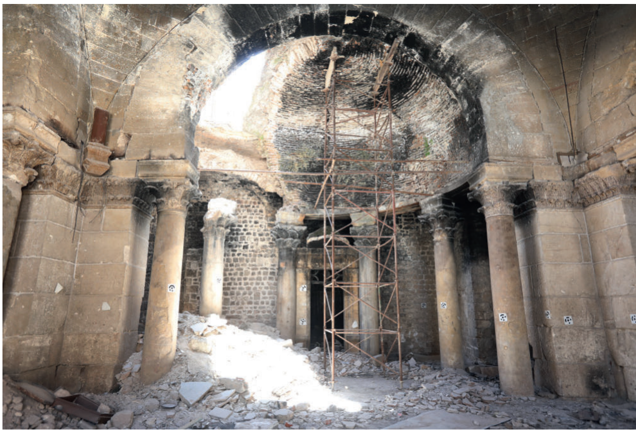
Рис. 2. Алеппо. Медресе Халавия. Интерьер, вид с востока Fig. 2. Aleppo. Madrasa Halawiyah. Interior, view from east
