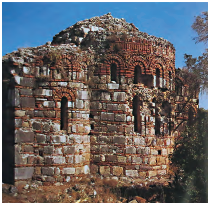
5. Восточный фасад храма на о. Кавхе Асар Ада на оз. Латмос (по А. Пешлов-Биндокат)
