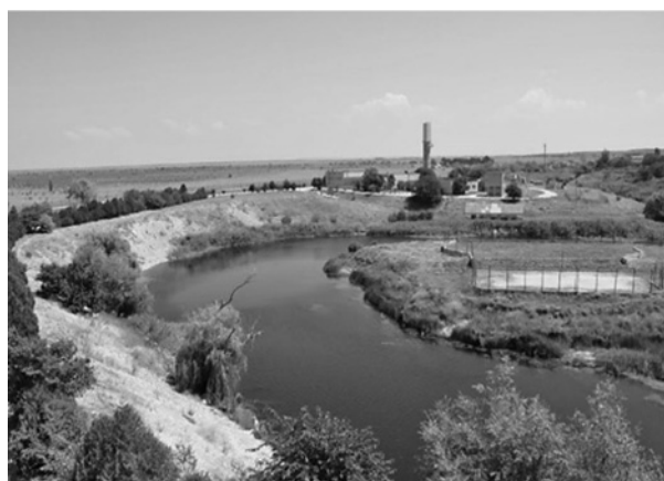
Рис. 2. Дамба с шандорным механизмом в устье реки Западный Булганак (фото авторов)
