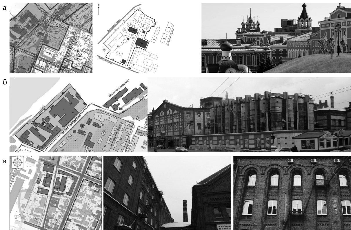
Рис. 5. Памятники архитектуры и градостроительства Самары: а – комплекс Самарского Иверского женского монастыря; б – Жигулевский пивоваренный завод; в – комплекс паровой мельницы Башкирова
