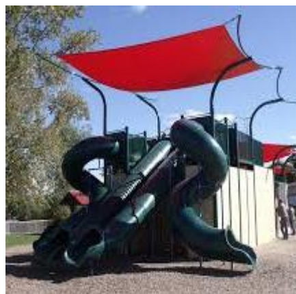
Рис. 17. Тентовое покрытие над сооружением детской площадки
