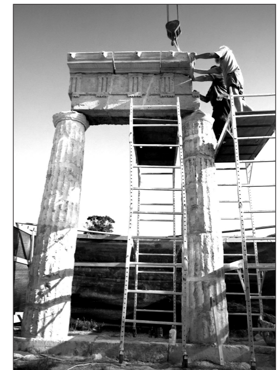
Рис. 4. Фрагмент колоннады Пританея в процессе восстановления. 2019 г.
