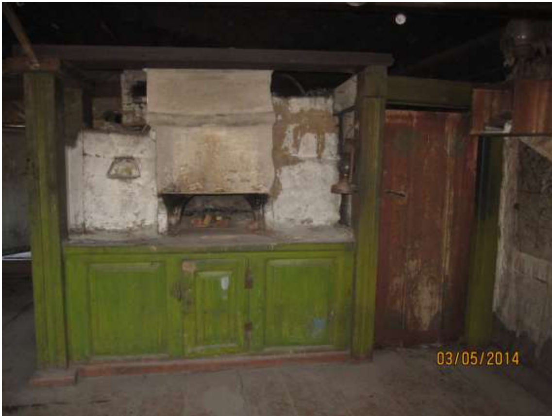
Ил. 2. Печь в доме М.М. Кичева до реставрации , д. Заручье МО «Липовское» Вельского района. 2014 г. Фото И.Л. Воиновой
