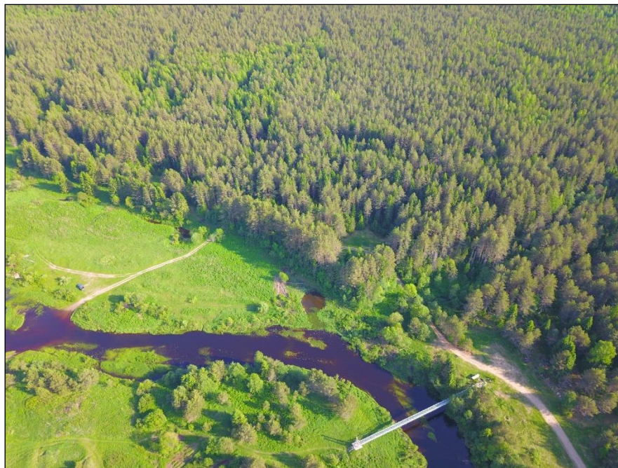
Рис. 1. Чудин Вал (в центре снимка) в левобережье р. Сямжена (июнь 2019 г.)
