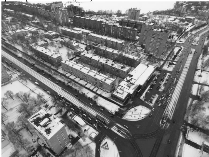
Рис.7. Перекресток ул. К. Маркса и Кирова в г.Ижевске
