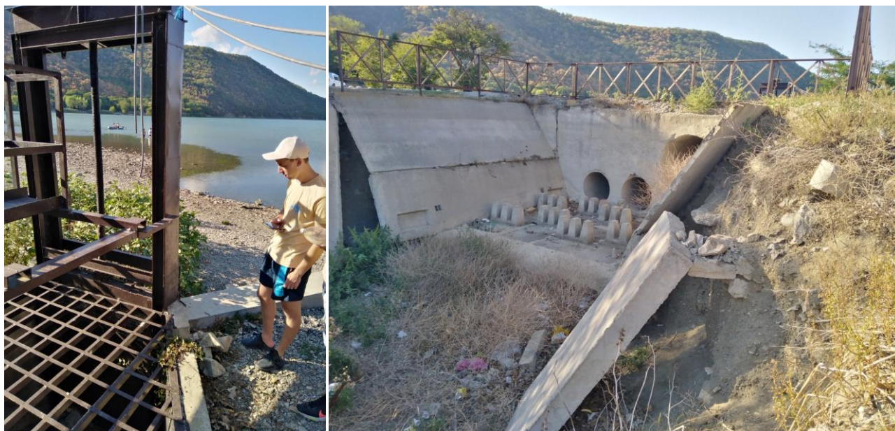
Рис. 9. Верхний шлюз водозабора (слева) и водовыпуск из озера Абрау в пруд-отстойник (фото авторов, 2020)
