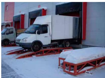
Рис. 13. Установка индивидуальных рампы для автотранспортных средств средней и малой грузоподъемности
