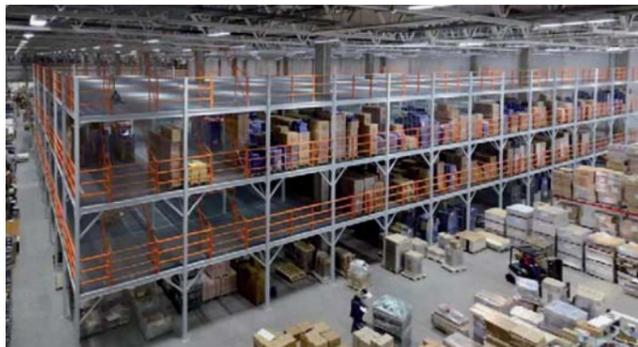
Рис. 4. Складской мезонин на колоннах со сплошным перекрытием
