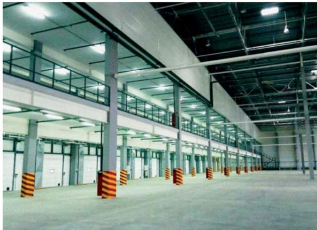
Рис. 1. Мезонин как конструктивный элемент склада
