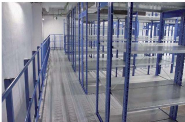
Рис. 5. Конструктивные особенности складского мезонина на стеллажных конструкциях
