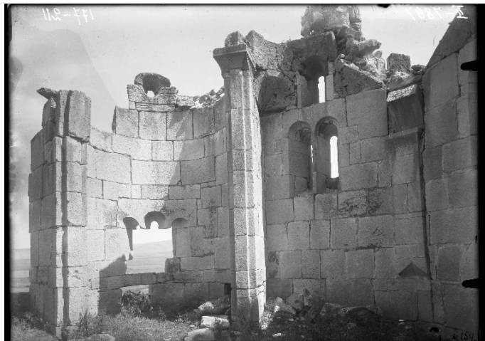
Ил. 18. Октагон, вид интерьера на юго-восток. Фотография Бульбенко. 1917 Fig. 18. The octagon's interior viewed to the south-east. Photographed by Bul'benko. 1917
