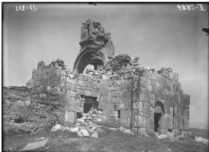
Ил. 24. Триконх, вид с юго-запада. Фотография Бульбенко. 1917 Fig. 24. The triconch viewed from the south-west. Photographed by Bul'benko. 1917
