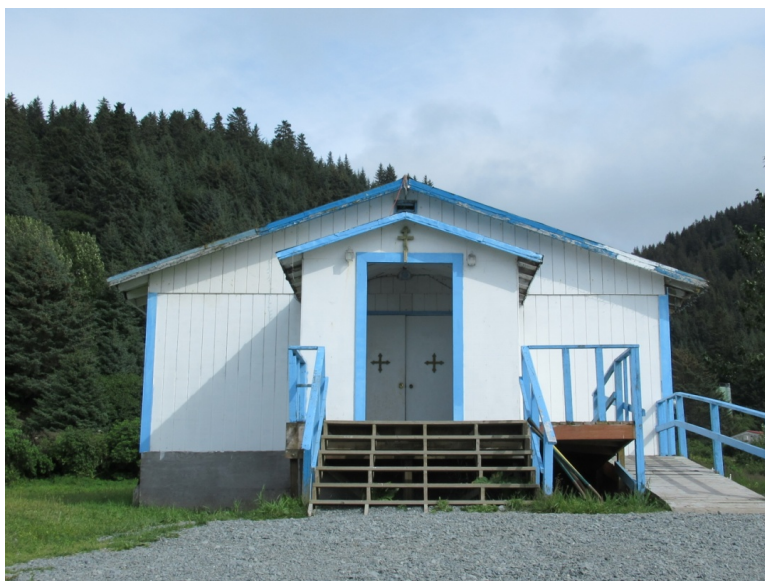
Фото 4. Церковь в пос. Нанвалек – вид снаружи
