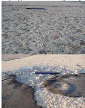
Рисунок 1. Шелушение глубиной от 1 до 5 см
