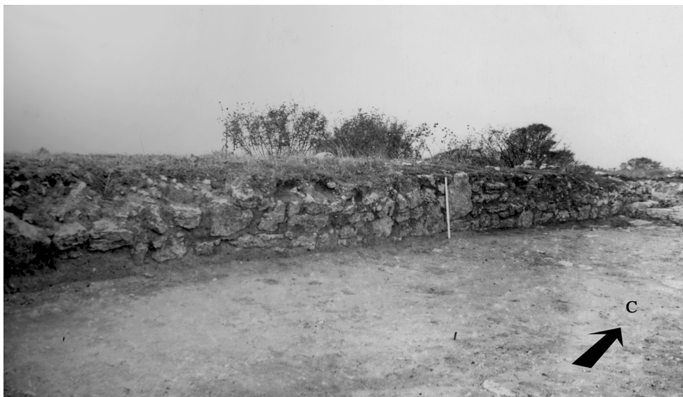
Рис. 4. Западная крепостная стена. Внутренний фасад. Южный блок. Свободное пространство. Вид с востока
