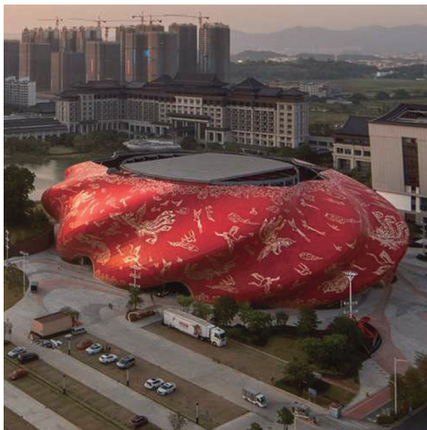
Илл. 6. Большой театр Санак в Гуанчжоу (арх. бюро “Steven Chilton Architects” 2020) Санак, КНР
