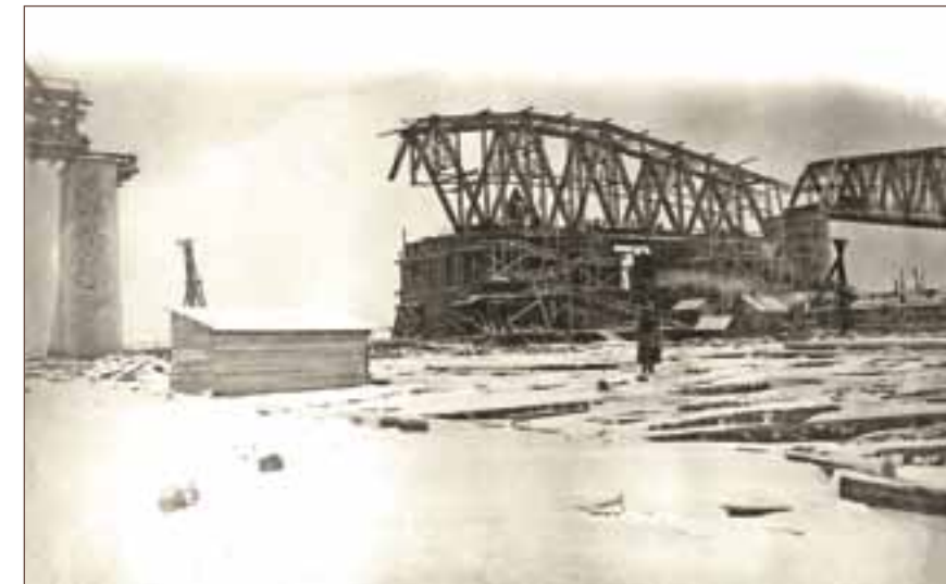
Восстановление железнодорожного моста через Каму. Фото из фондов ПКМ
