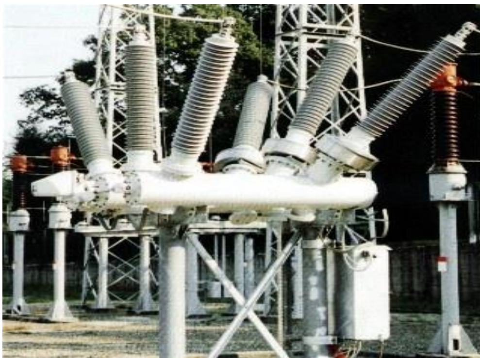
Рис. 2.15 - Устройства PASS (Plug And Switch System)
