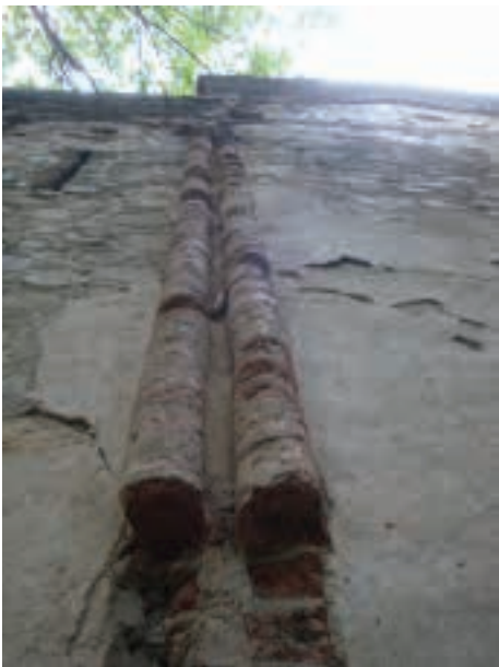
17. Акура. Мама-Давид. Параллельные жгуты из лекального кирпича на восточном фасаде
