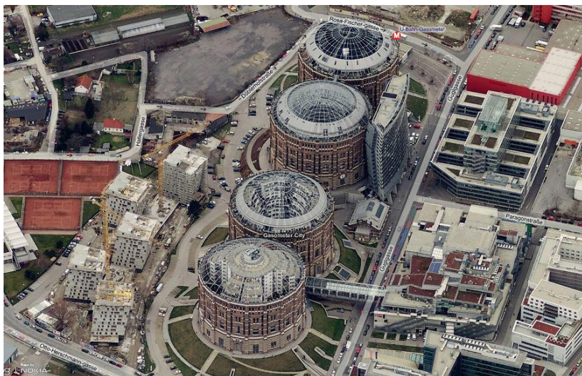
Рис. 2. Комплекс газгольдеров, г. Вена
