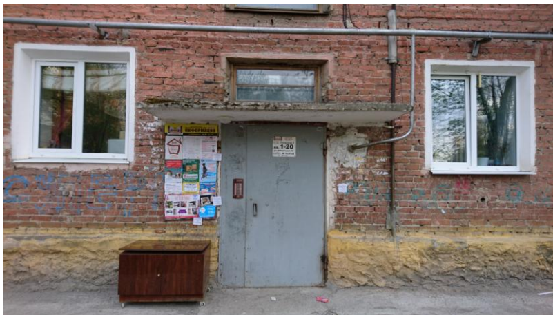
Рис. 2. Подъезд пятиэтажного дома, район Уралмаш
