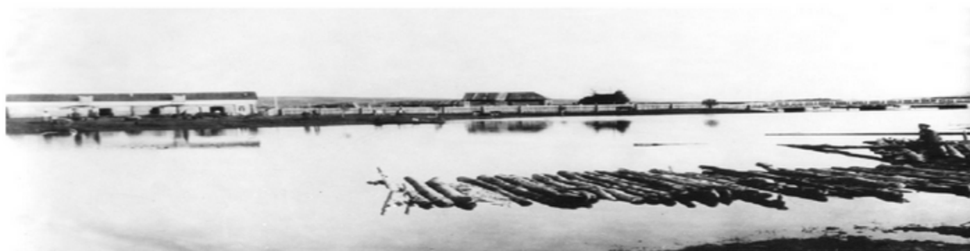
Плотина на р. Чапше
