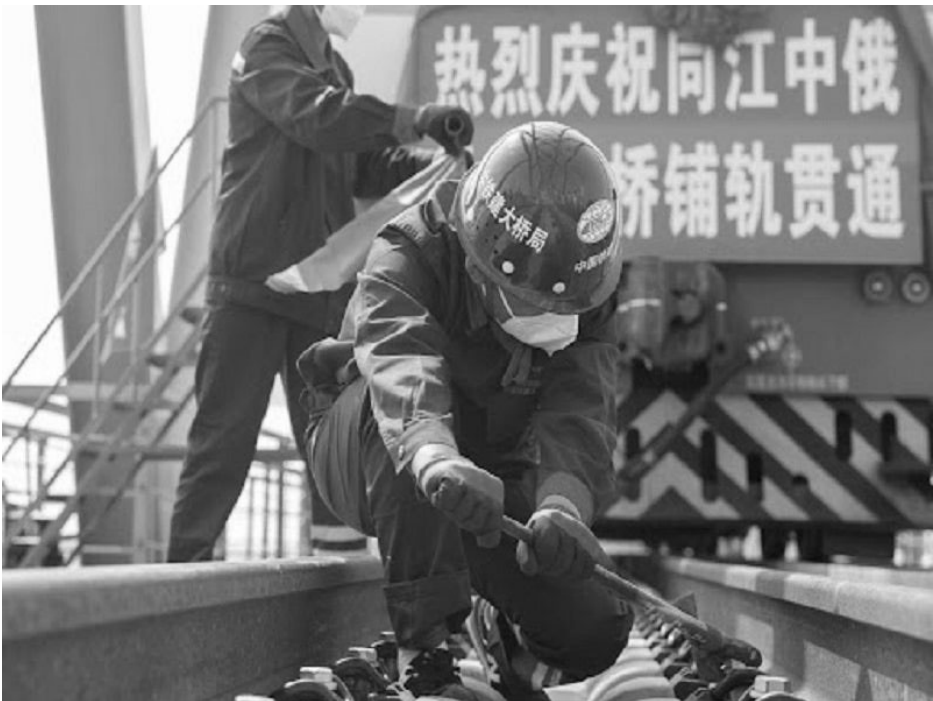
Eisenbahnbrücke Nižneleninskoe–Tongjiang über den Amur
