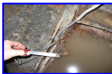
Рис. 4. Вид на чеканочный свинцовый шнур в стыковом соединении тубинга
