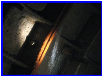
Рис. 1. Активная фильтрация воды через стыковое соединение между двумя тубингами
