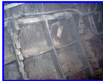
Рис. 2. Герметизация стыковых соединений между тубингами перед контрольным нагнетанием раствора (В/Ц=1)
