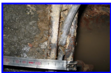
Рис. 3. Установка чеканочного шнура на неочищенные от ржавчины тубинги
